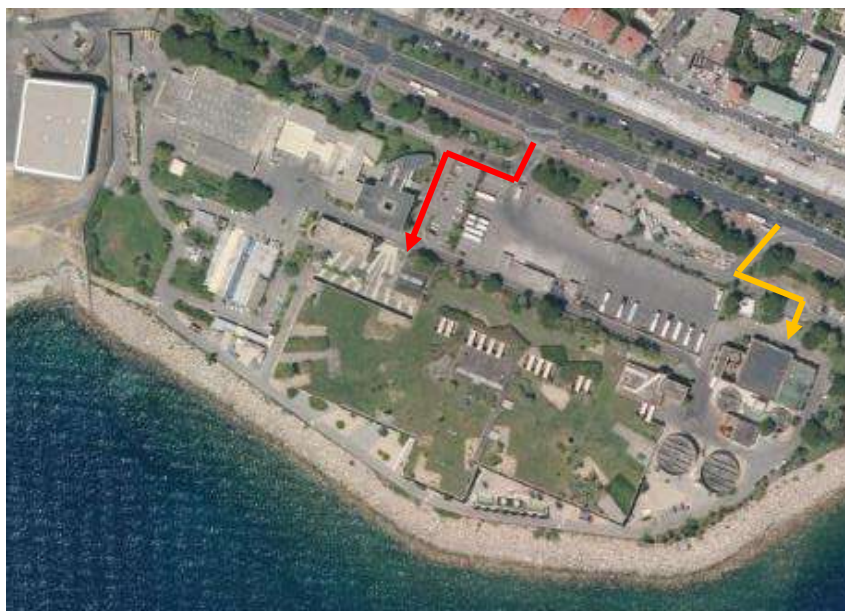
Figure 93: Accès au site HALIOTIS
